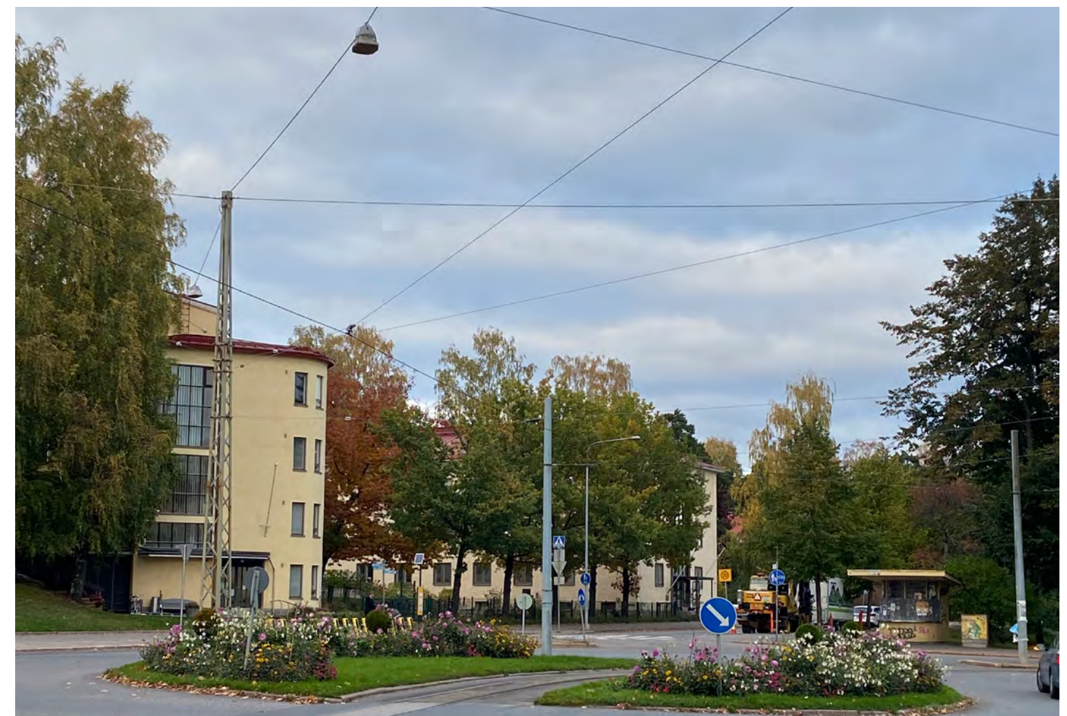
Kuva 29: Kannattimeton ajojohdinjärjestelmä Helsingissä
