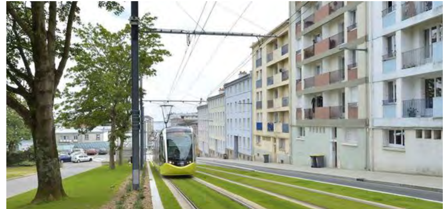
Kuva 28: Kannattimellinen ajojohdinjärjestelmä Brestissä
