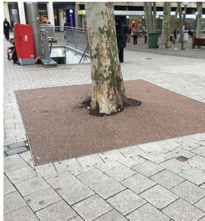
Kuva 17. Sidottu pinta on erotettu kiveyksestä upotetulla lattateräsreunalla.
