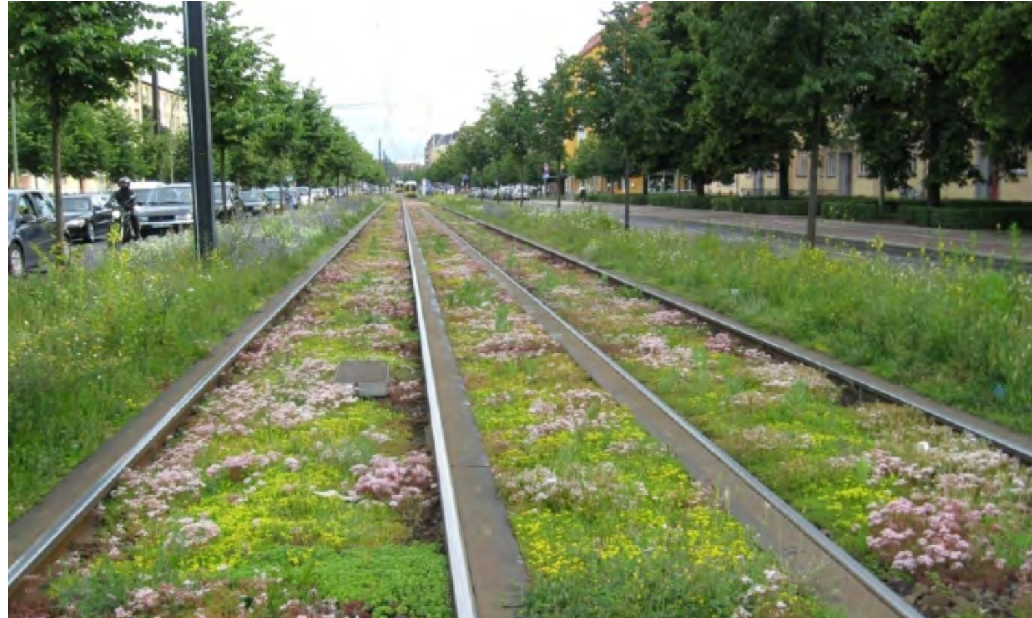
Kuva 15. Maksaruohopintainen raitiotie Berlinissä.
