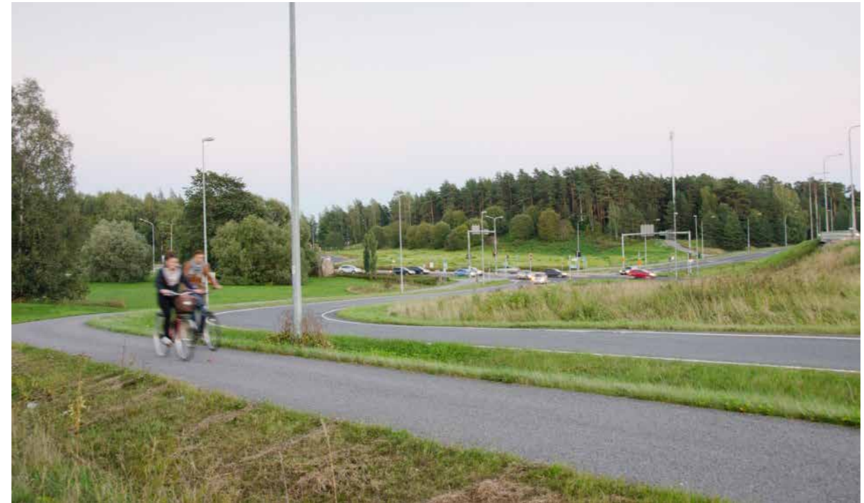
Kuva 49. Skanssiin raitiotie kulkee Hautausmaantieltä asti Uudenmaantien reunassa ohittaen eritasoliittymän rampin kuvan vasemmassa reunassa.
