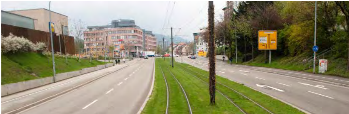
Kuva 54. Nurmetettu rata, Freiburg.
