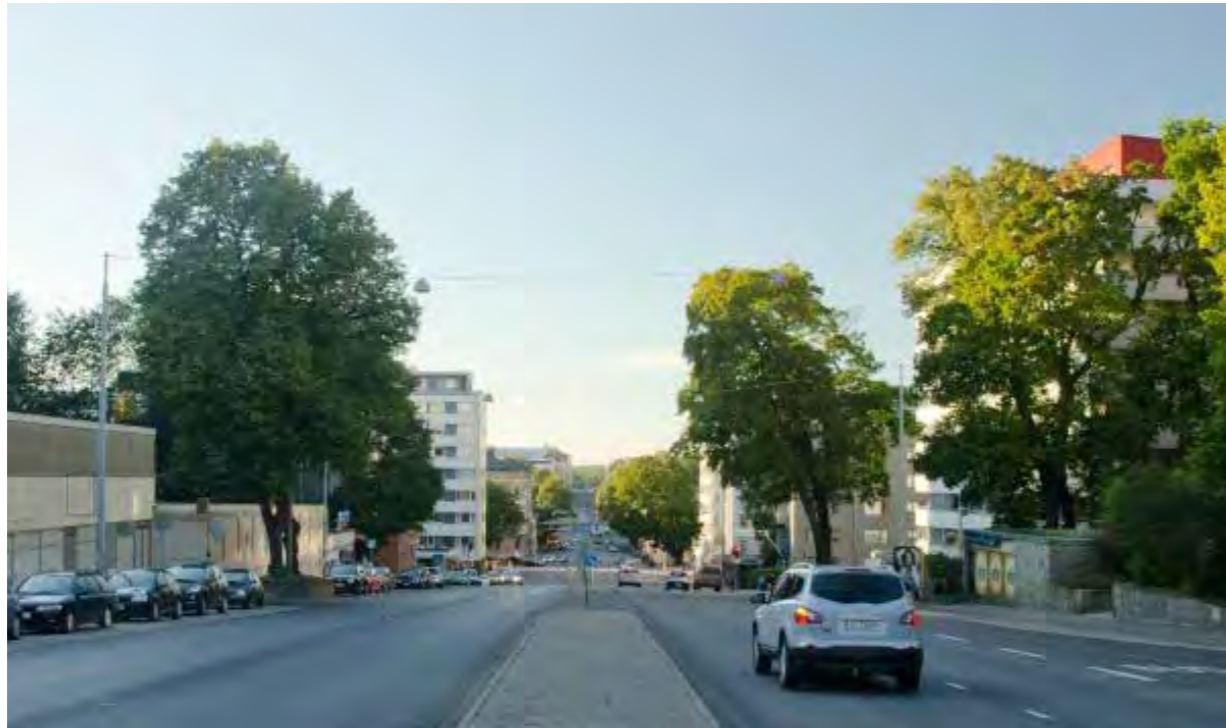
Kuva 48. Uudenmaantiellä raitiotie rakennetaan keskelle katua.
