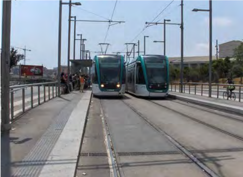
Kuva 62. Ajolankojen ripustus pylväissä radan reunoilla. Kuva: WSP
