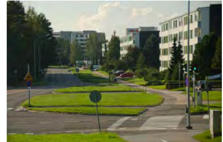
Kuva 45. Hepokullan kerrostalolähiön kohdalla raitiovaunuväylä rakennetaan ajoradan sekä erotetun pyörätien ja jalkakäytävän väliin.
