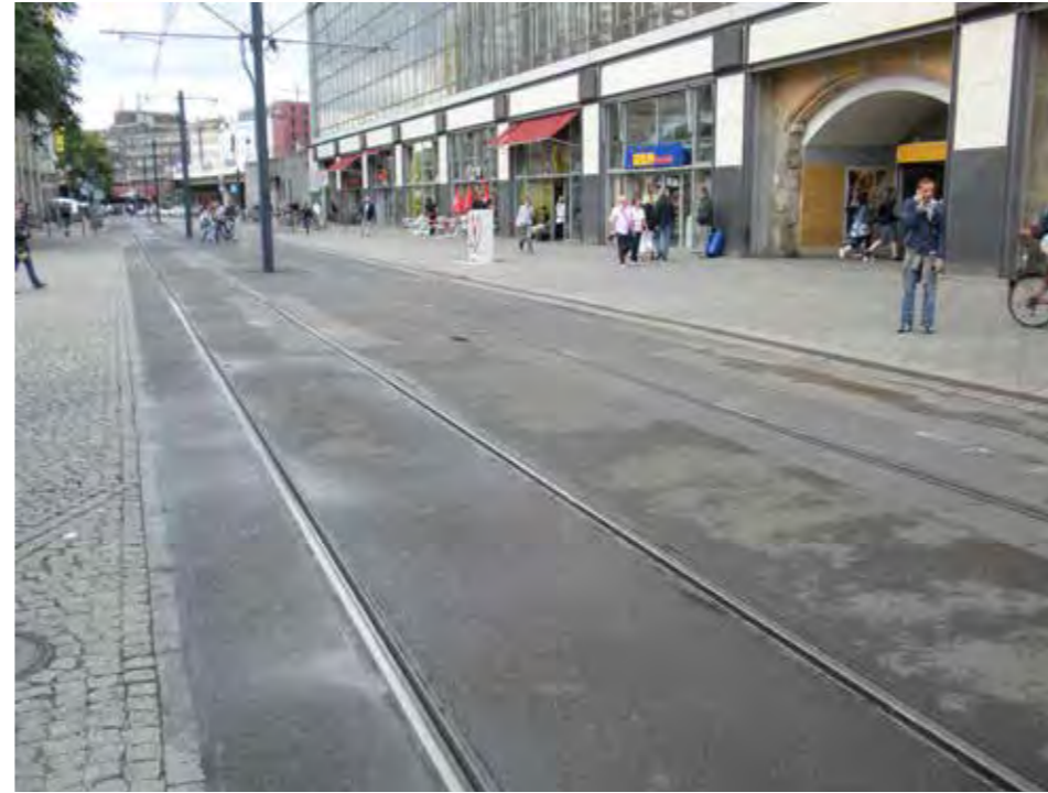
Kuva 61. Ajolankojen ripustus pylväissä radan keskellä. Kuva: WSP
