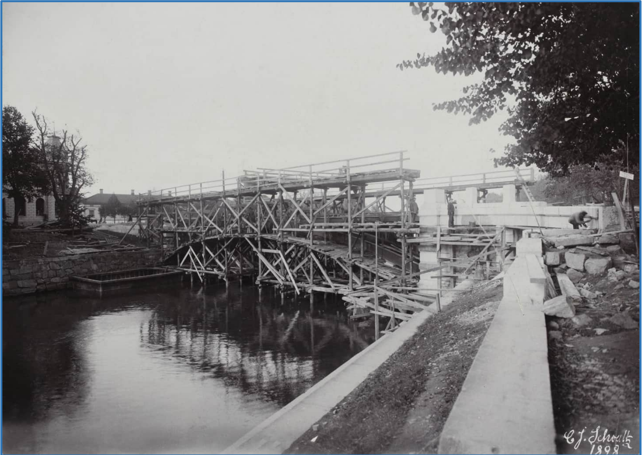
Kuva 5. Nykyinen Tuomiokirkkosilta rakenteilla vuonna 1898. Carl Johan Schoultz, valokuvaaja. Puiset rakennelmat ovat valmiit, kaarevat metallipalkit paikallaan ja kivityö on aloitettu. Kuvausvuosi 1898. Turun kaupunginmuseo Val695:1.
