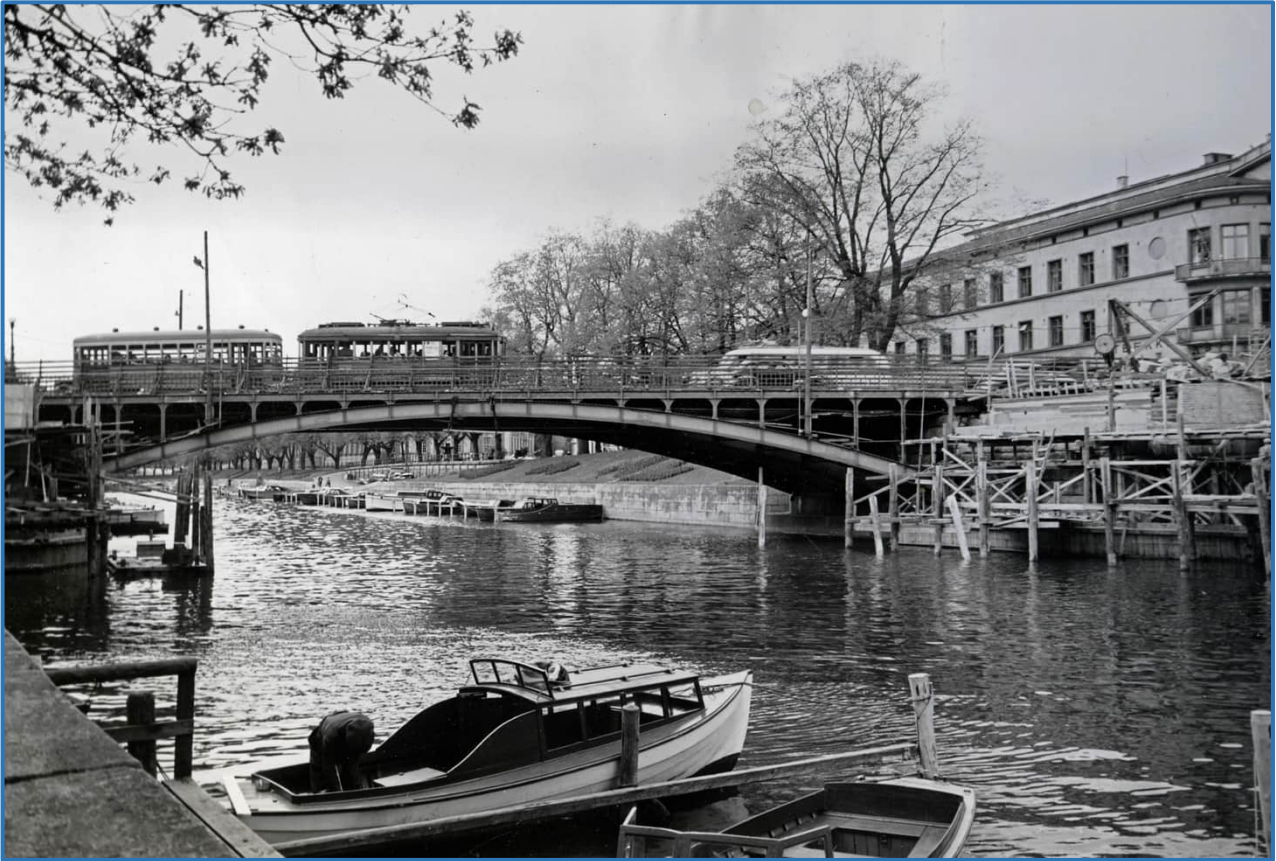
Kuva 6. Tuomiokirkkosilta kuvattuna vuonna 1952 kun sillan levennystyöt ovat jo käynnissä nelikaistaisesta kuusikaistaiseksi. Kuva on otettu alajuoksulle päin. Turun kaupungin museo. Tunniste DT2014:101:26.
