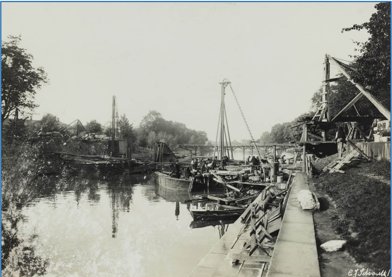
Kuva 4. Tuomiokirkkosiltaa rakennetaan vuonna 1898. Aurajoen yllittää puinen vanha silta, minkä edessä on uuden sillan työmaa. Vasemmalla rannalla paalutusjunta, keskellä kelluvalla rakennelmalla mahdollisesti nostolaite tai junta ja oikealla rannalla puinen mahdollisesti nostamiseen käytetty laiterakennelma. Valokuvaaja Carl Johan Schoultz. Turun kaupunginmuseo, N53122.
